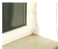
Figur 4.1. Foto af vindue: Misfarvning af tapet i murets ved vinduesplade.
